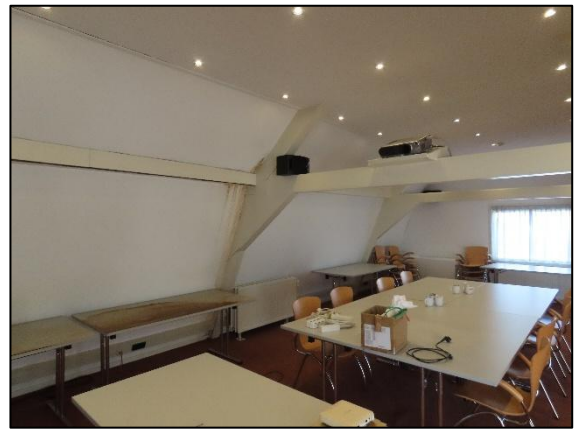
Fig. 1.17, Dakbeschot in Nieuw Baarnstraat 31 (bron: FF Solutions)
