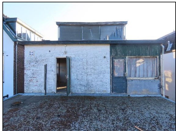
Fig. 1.5, Achterzijde van Nieuw Baarnstraat 33, gezien vanaf plat dak (bron: FF Solutions)
