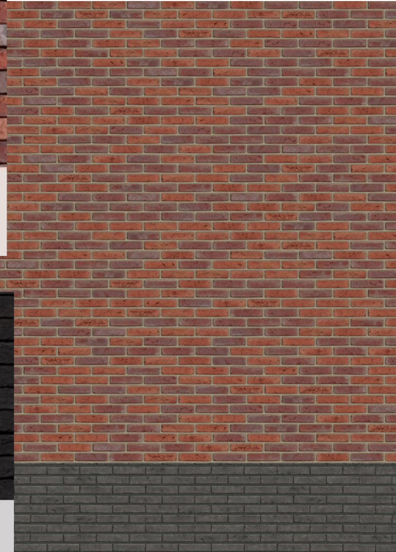
Metselwerk eerste verdieping achter volume
