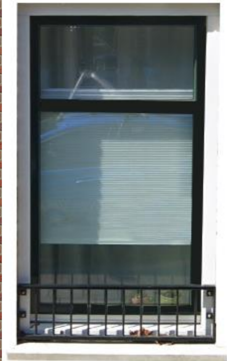
Finishing met kozijn
