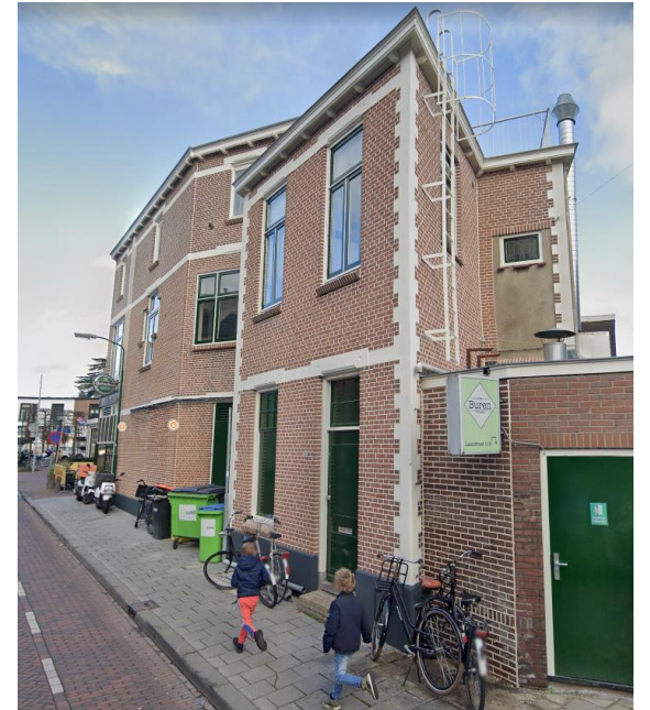
Tegenoverliggend gebouw, op de kruising tussen Laanstraat en Nieuw Baarnstraat
